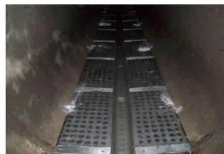
Wärmetauscher-Elemente von 1 m Länge werden im Kanal zu einem System zur Rückgewinnung der Abwasserwärme verbunden.
