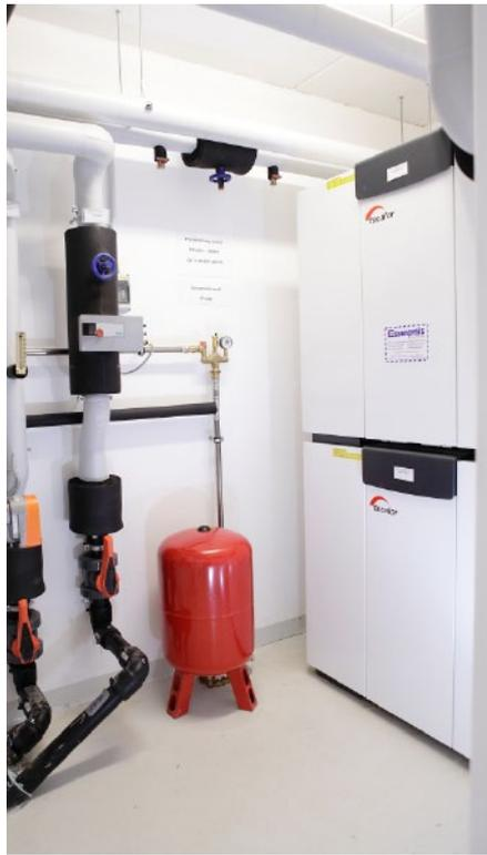
Elektrische Wärmepumpe Fabrikat Tecalor, zwei Stück TTF 20 GM. Jahresarbeitszahl 4,0. (Bild: Tecalor/Schu)
