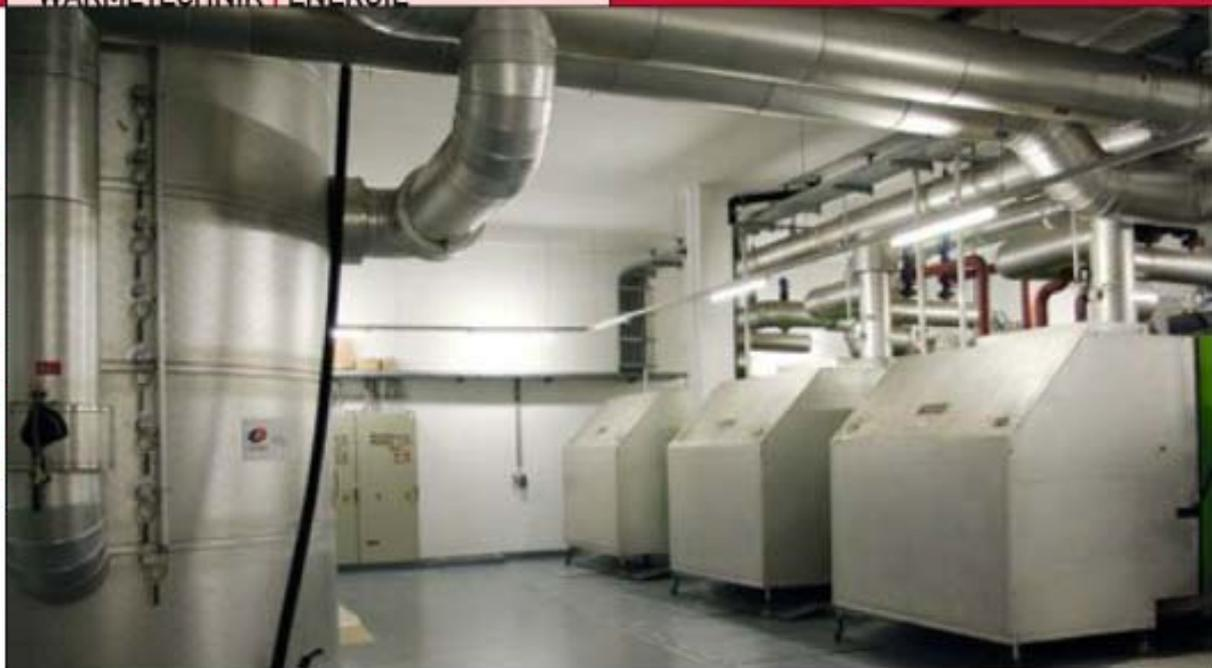
System-Förderpumpen in der Energiezentrale Augarten aufgrund der neuen Fernwärmeversorgung durch stärkere Einheiten ersetzt werden. Für die neuen Bezüger im Bereich der Überbauung Weiherfeld wurden über 1500 Meter neue Fernwärmeleitungen erstellt.
