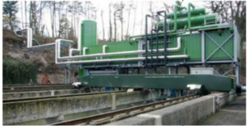
welchem eine höhere Effizienz (COP 4.1) erreicht werden kann als mit vergleichbaren synthetischen Kältemitteln. Zur Wärmepumpeanlage gehört ein Speicher mit einem Volumen von 50 m<sup>3</sup>, der für das Erreichen von hohen Betriebzeiten dient und die morgendliche Aufheizspitze bricht.
