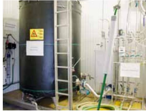
Die Versuchsanlage an der ART in Tänikon umfasst einen Fermenter mit 3'000 Liter Inhalt.
