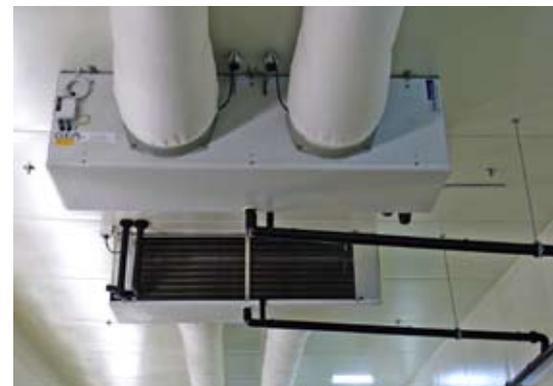
Neun Verdampfer mit Schlauchluftverteilern sind an den Decken platziert.
