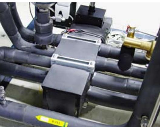
Die Expansions-Kompressions-Einheit wurde in der Kälteanlage integriert.
