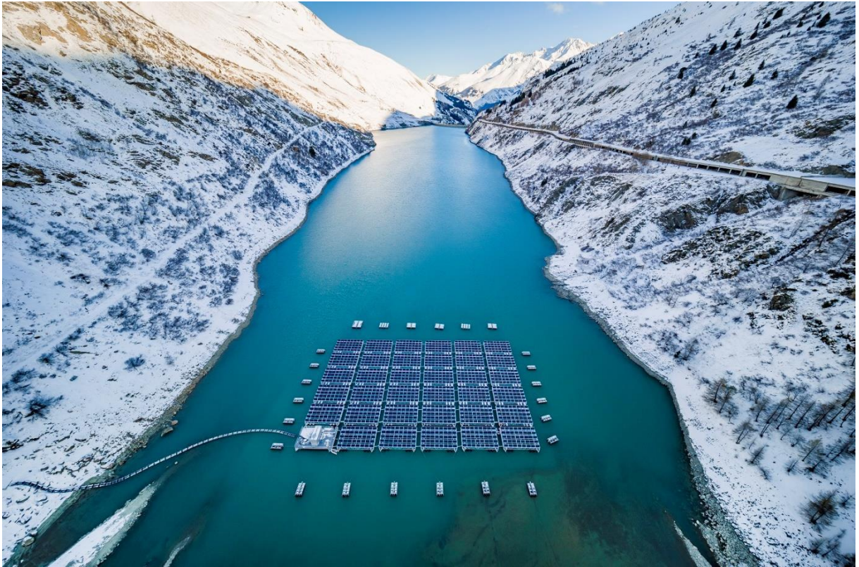
Projekt SI/501884-01: Schwimmende Photovoltaikanlage auf dem Lac des Toules (VS)
