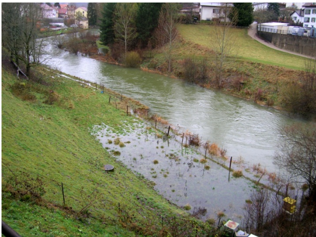
Überschwemmte Gebiete bei mittlerem Abfluss (ca. 25 m 3 /s)
