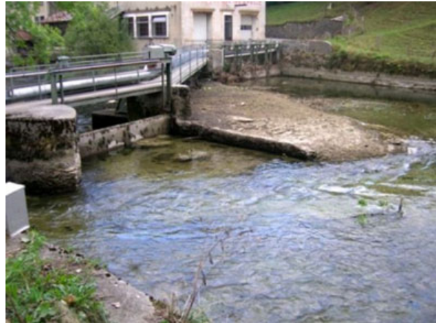
Aktuelle Situation oberhalb der Schwelle bei tiefem Wasserstand (ca. 2.5 m 3 /s)
