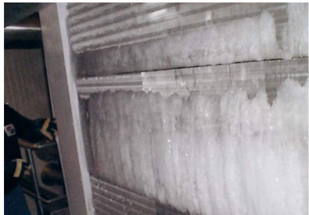
Bild: Vereister Verdampfer. Nur noch ein Teil der Fläche wird von Luft durchströmt.
