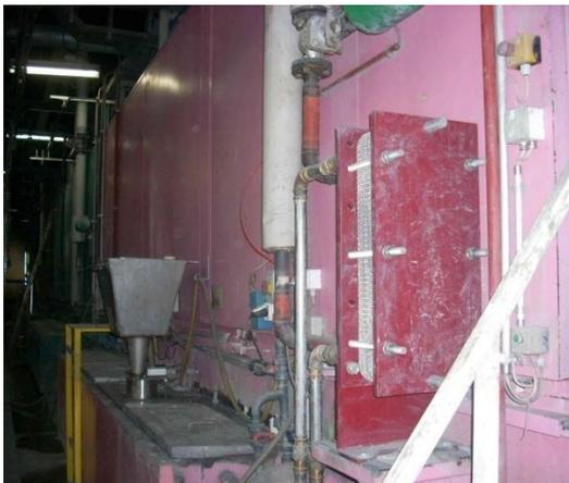
Abbildung 3-2 Entfettungsbad mit Wärmetauscher
