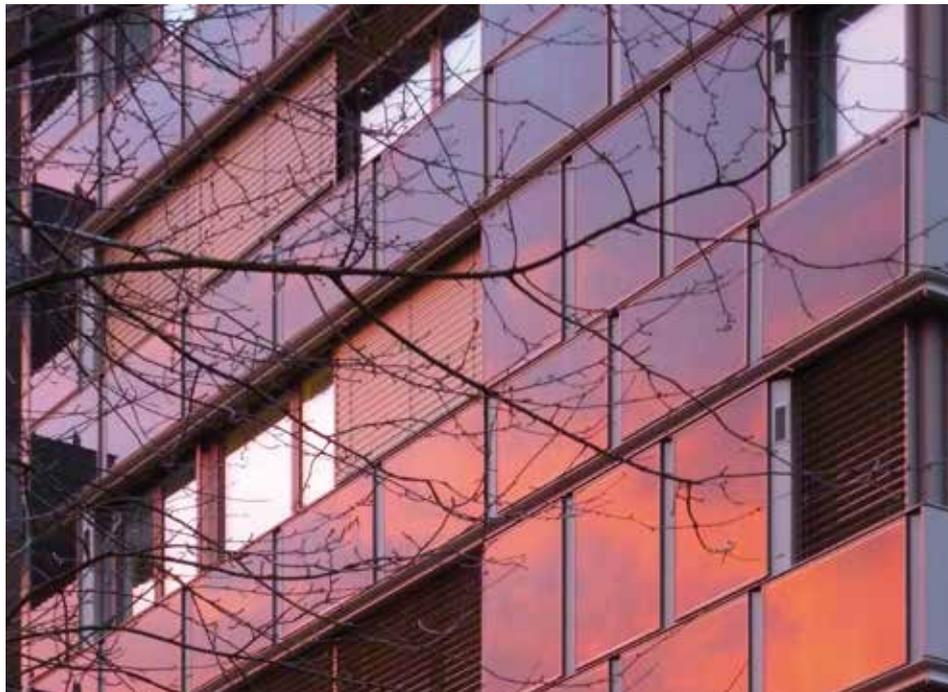
*Die PV-Fassade generiert nicht nur Energie, sondern bringt auch optisch eine deutliche Aufwertung. (Foto: Harder Haas P. AG)*
