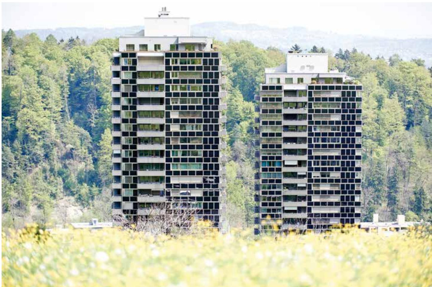
Die beiden markanten Hochhäuser kommen nicht mehr in Grau daher, sondern mit einer eleganten Fassade aus PV-Panels. (Foto: Zeljko Gataric)
