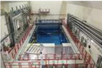
Brennelemente werden auch in Kernkraftwerken zwischengelagert (Bild: Nasslager im Kernkraftwerk Gösgen). Quelle: Kernkraftwerk Gösgen
