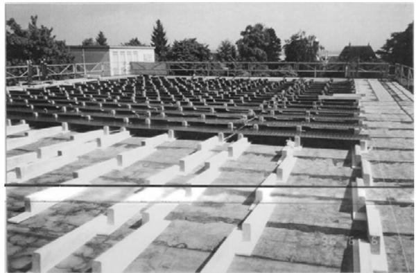
*Image 6 : Pose des tubes enterrés pour la création du stock – Collège des Coteaux – Peseux - NE*
