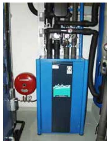
Grosses Einfamilienhaus in Genf: eine Wärmepumpe mit Erdwärmesonden von 40 kW ermöglicht die kombinierte Produktion von Warmwasser für die Raumheizung, Gebrauchswarmwasser und solchem für das Schwimmbaden sowie von Kaltwasser für die Kühlung der Räume. Die Wärmeproduktion wird durch die Wärmepumpe geregelt, während ein programmierbarer industrieller Automat die Kälteproduktion, die Flüsse zwischen den Speichern und den Erdwärmesonden sowie die Fernüberwachung steuert.
