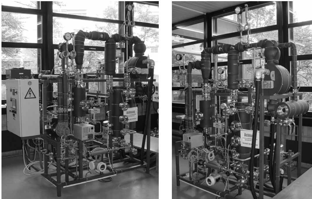
Bild 6: Gesamtansicht der Wärmepumpe.
