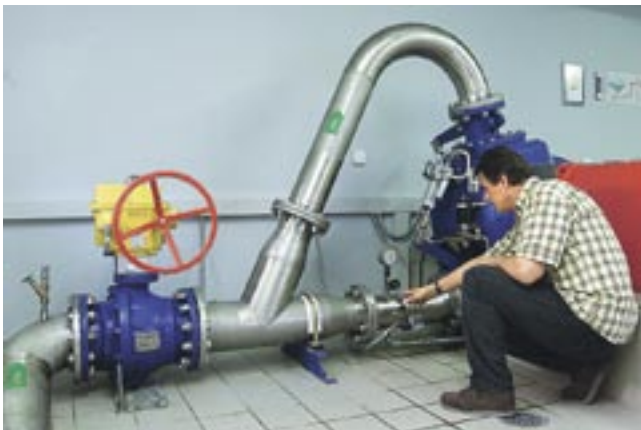
Die 150-kW-Pelton turbine im Reservoir St. Hilarien.
