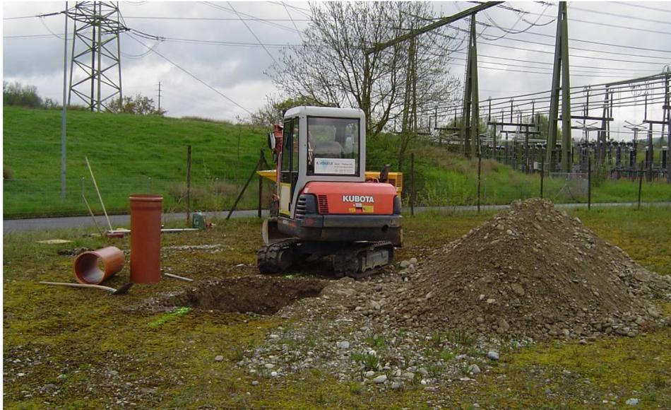
Darstellung 4.10-11: Baggerschlitz mit gut sichtbarem Trennflies. Tiefe insgesamt ca. 2 m. Die Schicht unter dem Flies ist gräulich, lehmig und teilweise sehr nass.
