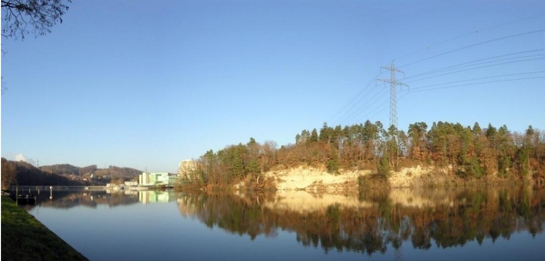
Die Breite des Oberwasserkanals beträgt 66-68 m und die Breite der Gewässersohle 43-44 m (Darstellung 4.8-2). Die Wassertiefe beträgt durchwegs rund 6.3 m. Der Böschungswinkel ist 2:3.
