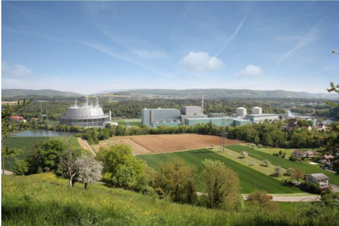
Links der Hybridkühlturm, Mitte das Maschinenhaus mit Nebenkühlwasserzellen im Vordergrund, rechts davon das Reaktor- und das Reaktornebengebäude (mit Abluftkamin). Die Brennelemente-Zwischenlager im Vordergrund, daneben das Lager für schwach- und mittelaktive Abfälle. Ganz rechts KKB 1 und 2.
