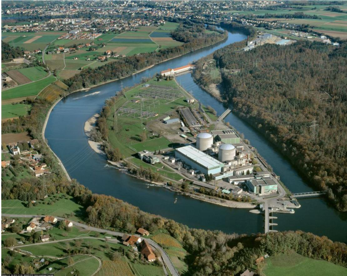
Im Vordergrund das Stauwehr Beznau und rechts die Refuna Rohrbrücke. Im Hintergrund das hydraulische Kraftwerk am Ende des Oberwasserkanals. Das Kernkraftwerk KKB 1 und 2 steht im Mittelgrund. Das Zwischenlager (ZWIBEZ) mit seiner grünen Fassade liegt etwas südlich der Strassenbrücke.
