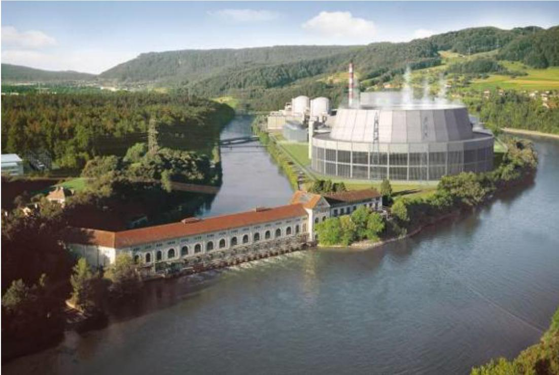
Im Vordergrund das Wasserkraftwerk und der Hybridkühlturm, links davon Nebenkühlwasserzellen. Hinten ZWIBEZ und KKB 1 und 2. Ganz links hinter den Wohnhäusern ist die neue Schaltanlage des Überlandnetzes im Stüdliau sichtbar. Die entsprechenden Hochspannungsmasten sind vor dem Kühlturm und im Wald zu sehen.
