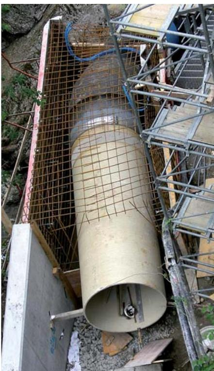
**Bild 5.** Verlegen der glasfaserverstärkten Druckleitung..
