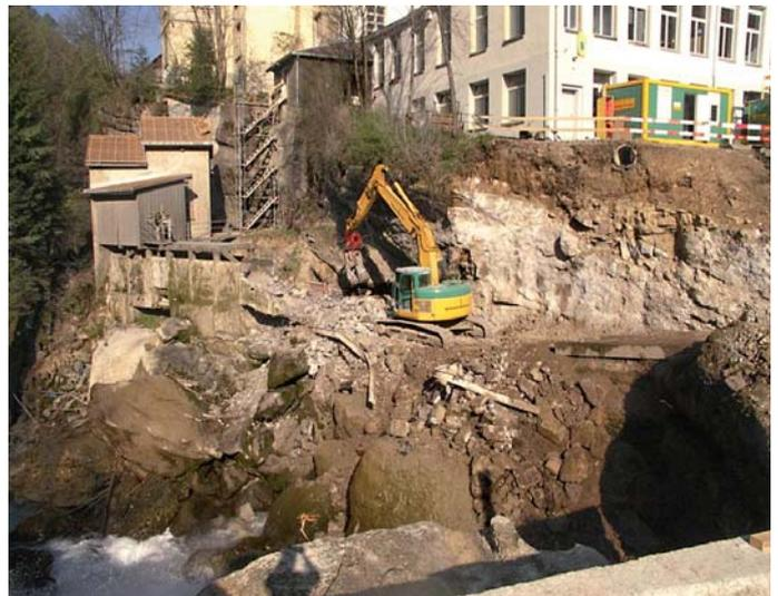
**Bild 4.** Bauarbeiten für den geplanten Entsander-Teil im Einlaufbereich.
