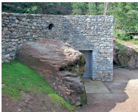
Das Trinkwasserkraftwerk nach dem Vorbild der traditionellen Tessiner Häuser. Foto: Premel SA
