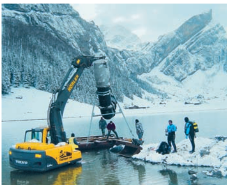
2005 wurde das Kleinwasserkraftwerk Seealpsee-Wasserauen umfassend saniert und ausgebaut
