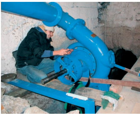
Einbau der Turbine anlässlich der Sanierung
