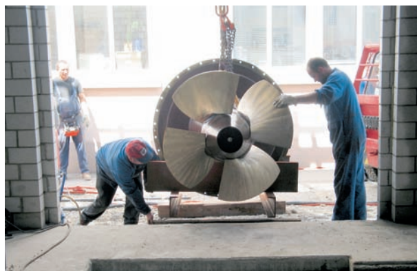
Einbau einer Kaplan-Turbine mit einer Leistung von 125 kW ins KW Emmenau in Hasle-Rüegsau. Foto: ADEV
