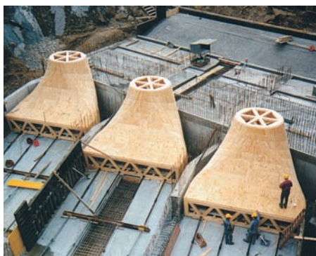
Die Schalungen der drei Saugrohre. Foto: Iteco AG
