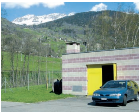
In diesem Gebäude wird das Abwasser turbinieren. Foto: Mhylab
