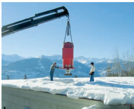
Die Turbine wird eingebaut. Foto: Gemeinde Savièse und Gasa SA
