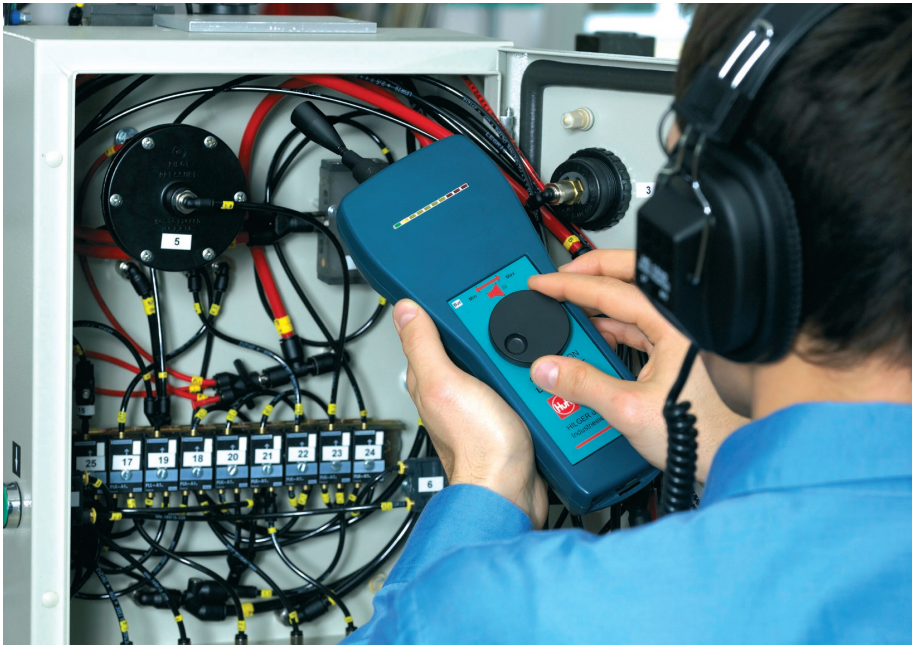
Leak-Detect im Einsatz
