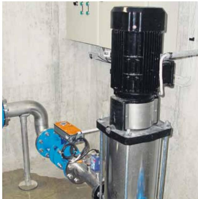
Die Turbine im Druckausgleichsschacht Gurtberg liefert Strom für fünf Haushalte.
