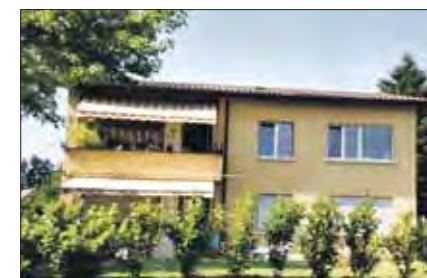
Das Zweifamilienhaus vor Sanierung, Umbau und Anbau
