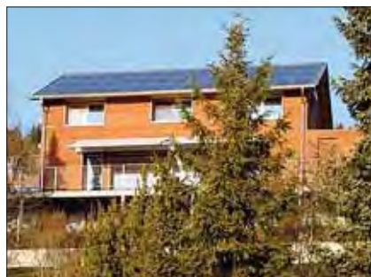
... über die grosszügige Sonnenenergienutzung ...
