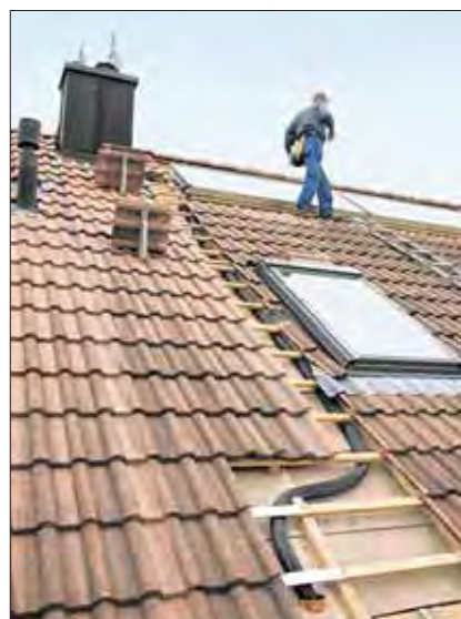
15.15 Uhr: Die Leitung wird fachmännisch verlegt.
