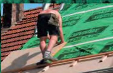
Die perfekte Lösung für Dachsanierungen: Die Kombination aus PAVATHERM-PLUS\*, PAVATEX LDB 0.02 Luftdichtbahn und PAVAFLEX.
