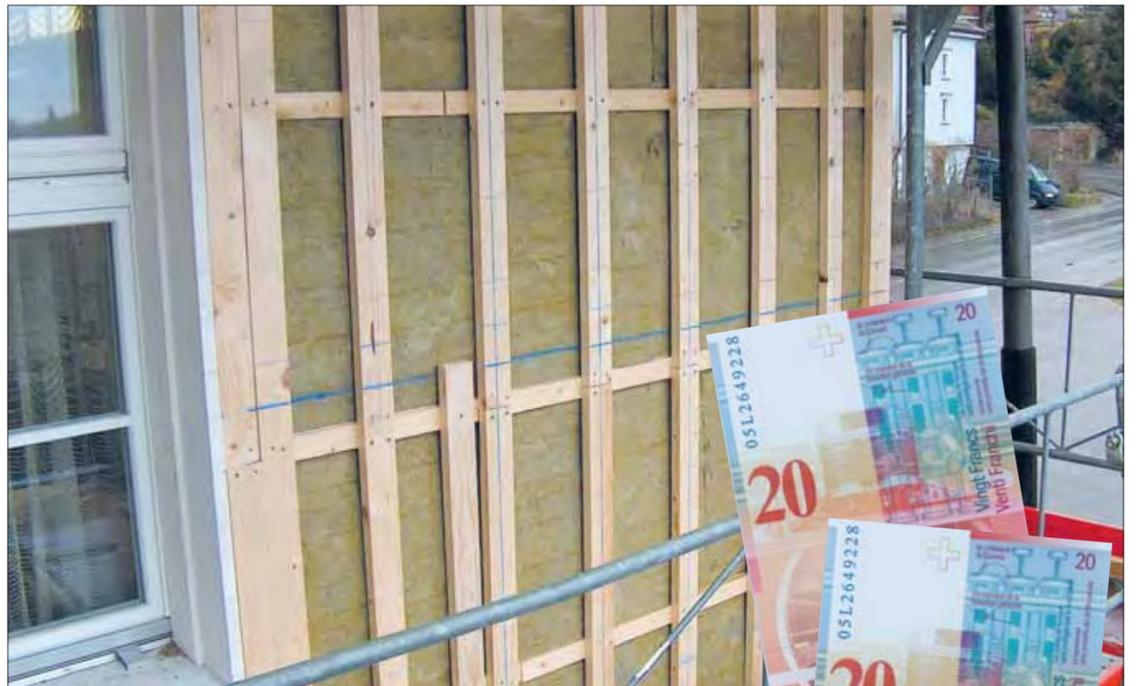
Die Anforderungen an die Wärmedämmung der Fassade können Sie bereits mit einer Dämmschicht von 16 cm erfüllen. Fachleute empfehlen 16 bis 20 cm oder mehr. Sparen Sie also nicht beim Dämmstoff, denn Sie können später nicht einfach nachdämmen und eine weitere Dämmschicht aufpappen, sondern müssen nochmals von vorn beginnen.
