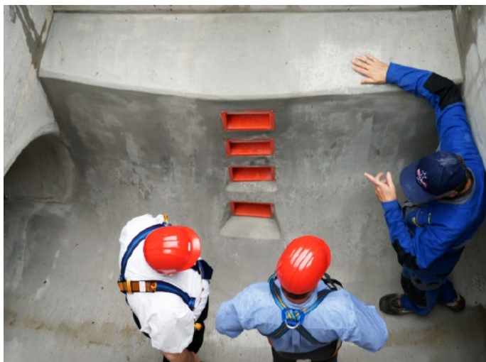
Abwasserkanal mit bereits fertig eingebauten Wärmetauscherelementen der Abwasserwärme-Anlage Wässerwiesen Winterthur. Die im Contracting ausgeführte Anlage wird Anfang 2010 ihren Betrieb aufnehmen. (Bild: EBM)
