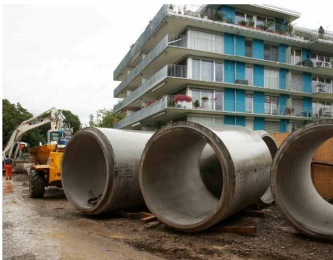
Bauarbeiten rund um die Erstellung des neuen Abwasserkanals für die Abwasserwärme-Anlage Wässerwiesen für rund 400 Wohnungen beziehungsweise 1000 Bewohner. (Bild: zVg)
