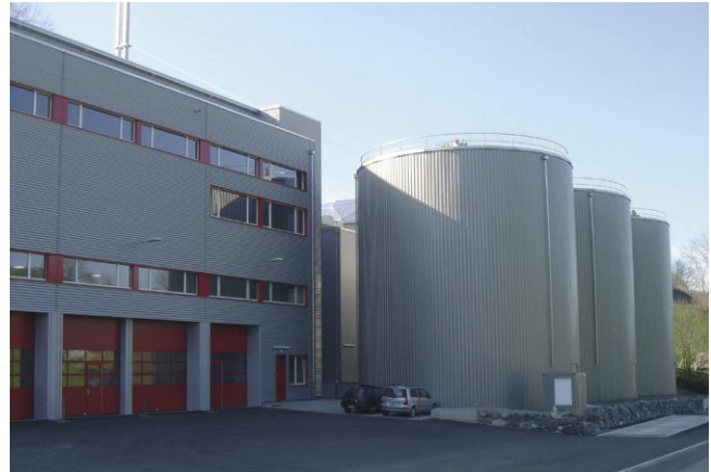
Die Biogasanlage Schwellbrunn hat drei Fermenter.
