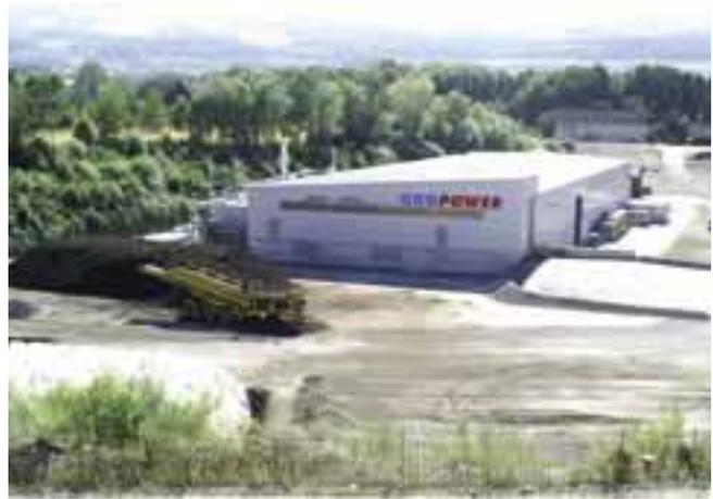
Ökopower-Anlage, System Kompogas, mit 16'000 t/a Verarbeitungskapazität
