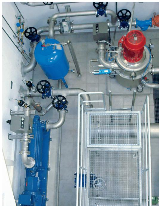
Abb. 2 Blick in den Maschinenraum des Reservoirs Grundhilti: oben die vertikale Gegendruck-Pelton-turbine, links die Bereitschaftspumpe der Notwasserversorgung. (Quelle: Gemeindewerk Fällanden)
