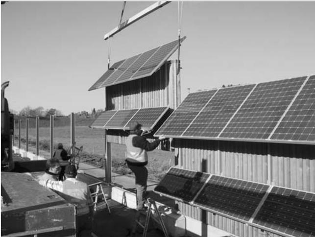
Montage an der Autobahn: Lärmschutzwände mit Photovoltaik-Modulen (Bild: Atelier Hottiger)
