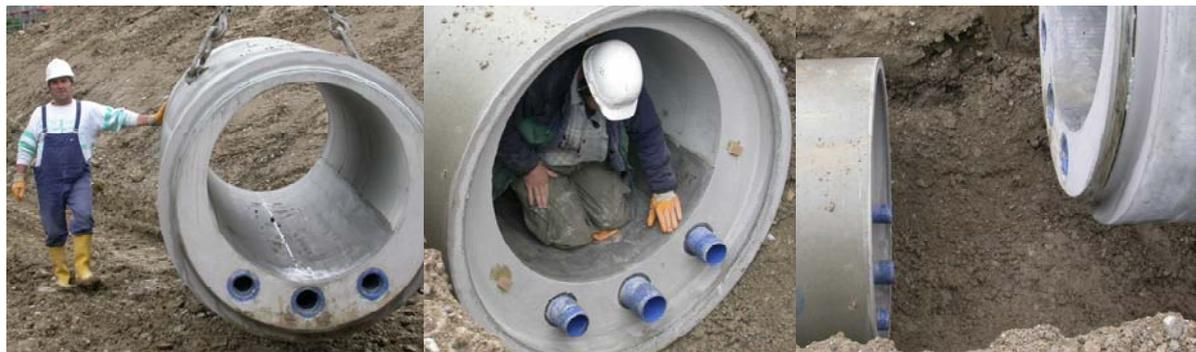
**Rinnenwärmetauscher als vorgefertigte Elemente**
