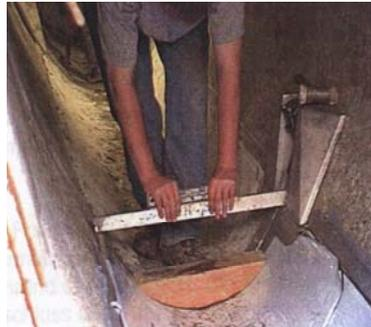
WT-Element wird präzise auf der Kanalsohle platziert
