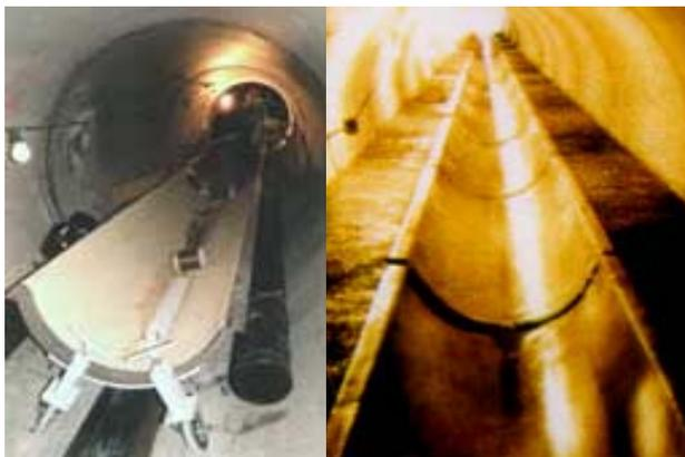
**Querschnitt durch Kanal mit Wärmetauscher**
