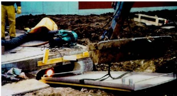
**Reinigung des montierten WT im Kanal**
