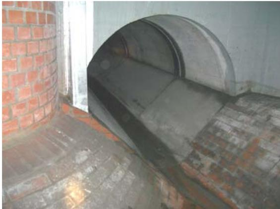
**Übergang Schachtsohle Wärmetauscherkanal**
