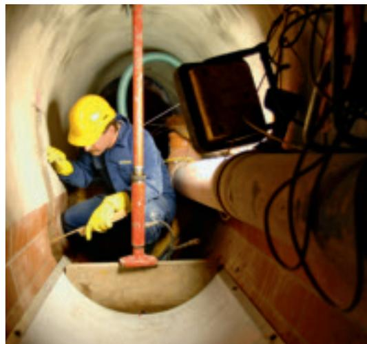
Abb. 2 Einbau eines Rinnenwärmetauschers in einen Abwasserkanal: In Solothurn wurden im Rahmen des GEP geeignete Kanäle für die Abwasserwärmenutzung systematisch ermittelt.
