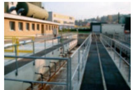
Abb. 11 Becken des Membran-Belüftungsverfahrens.
