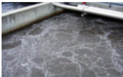
Abb. 7 Nitrifikationsbecken mit Trägerkörpern.
