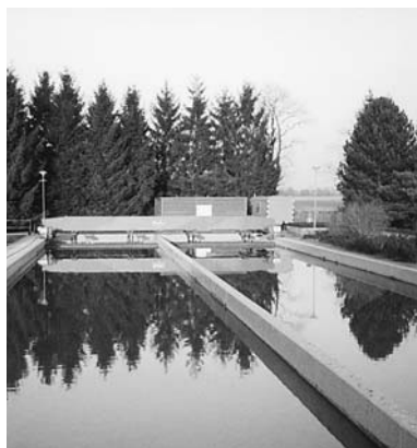
Regenklärbecken und Vorklärbecken
