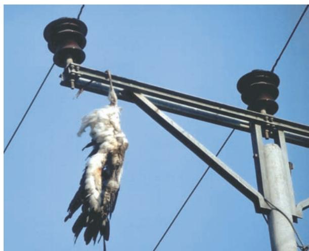
*Abb. 2: An einem Mast mit Stützisolatoren durch Stromschlag umgekommener Weissstorch. Ein zweiter Weissstorch lag tot am Boden. (Bild: G. Fiedler)*
