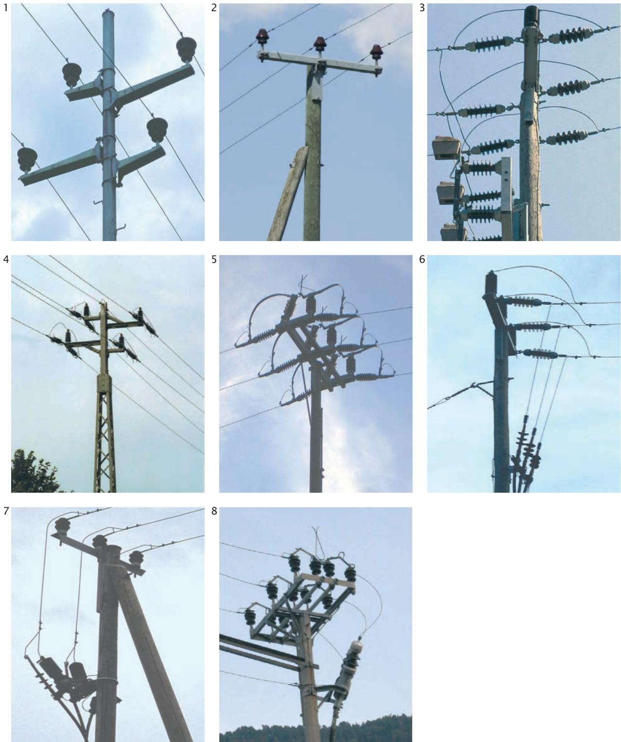
*Abb. 4: Die meisten Unfälle geschehen bei Masten mit Stützisolatoren und Leitern oberhalb der Traverse (1-8), gefährlich konstruierten Mastschaltern (5, 8) und bei Endmasten (mit oder ohne Mastschalter 6-8). (Bilder: A. Aebischer und SBB)*
