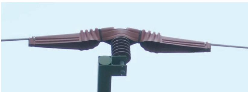
*Abb. 7: Stützisolatoren mit Abdeckhauben. Isolierendes Abdeckmaterial soll die Leiter beidseits von Isolatoren auf einer Länge von mindestens 60 cm abdecken.
