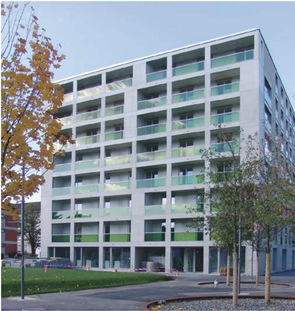
Die 152 Wohnungen der neuen Siedlung Werdwies in Zürich-West liegen bezüglich Energieverbrauch weit unter dem MINERGIE®-Standard. Möglich ist diese Qualität aufgrund der guten Wärmedämmung, der mechanischen Lüftung und der äusserst kompakten Bauweise.
