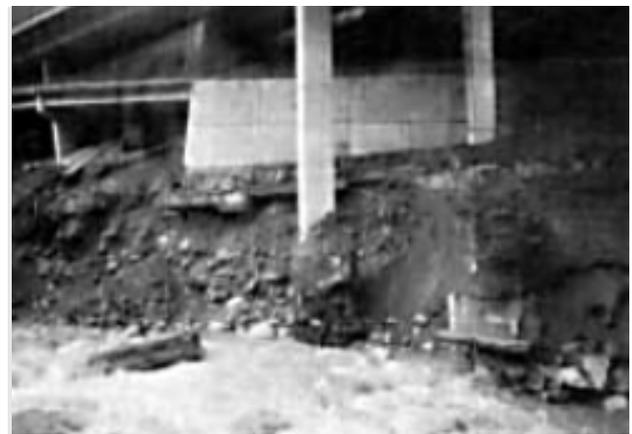
*Freigelegte Fundation eines Landpfeilers durch Seitenerosion während Hochwasser*
