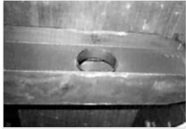
*Chloridablagerungen an der Untersicht einer Stahlverbundbrücke*
