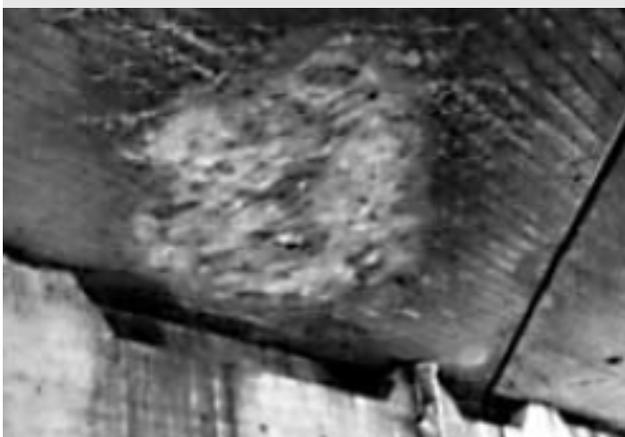
*Ablagerungen und Ausblühungen an der Untersicht einer Brücke*
