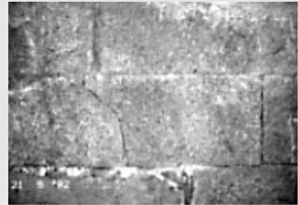
Risse durchlaufend durch Mauersteine
