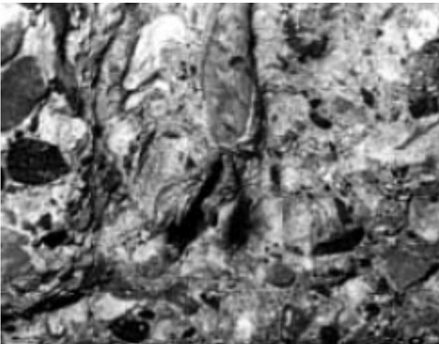
*Bild 2.40 Nicht zurückgebogene Bindedrähte weisen eine ungenügende Betonüberdeckung auf*
