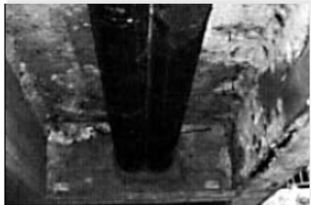
*Fahrbahnplatte FP zwischen den Trägern T1 und T2, Blick gegen Querträger Q: Kalkablagerungen und örtliche Bewehrungskorrosion infolge eindringendem Wasser durch Fahrbahnplatte*
