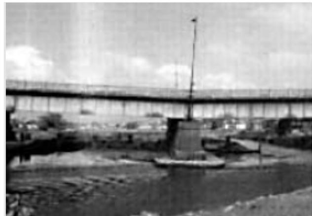
*Unterkolkung der Fundation eines Strompfeilers*
