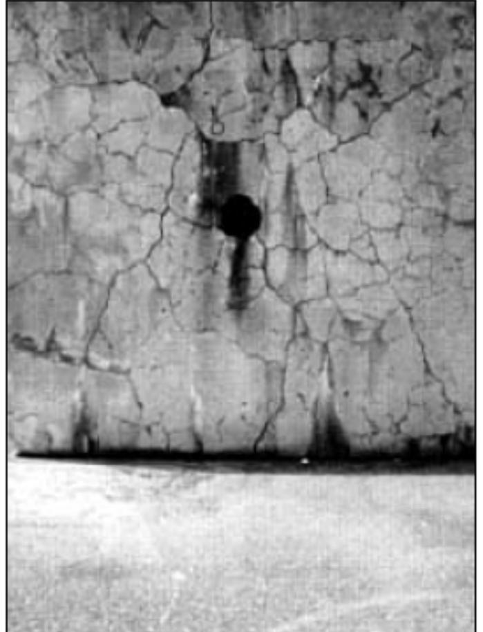
Bild 2.16 Sulfattreiben von Beton
