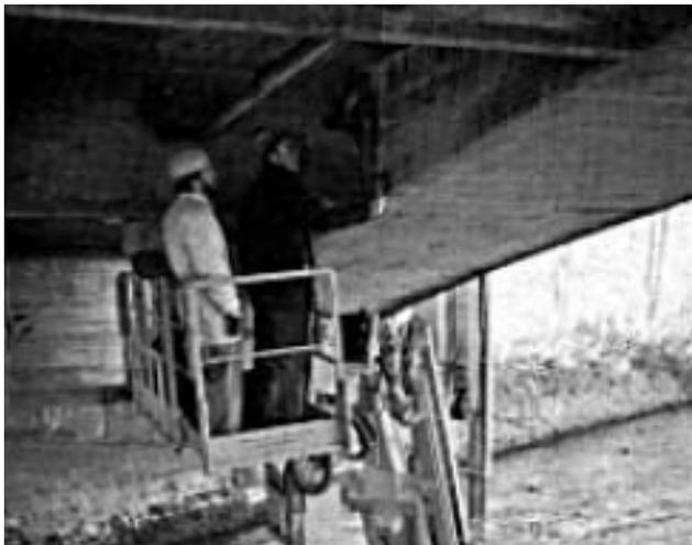
Bild 5.6 Untersichtgerät im Einsatz bei einer Brückenuntersuchung
