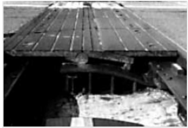
*Wasserundichtigkeit eines Fahrbahnüberganges*
