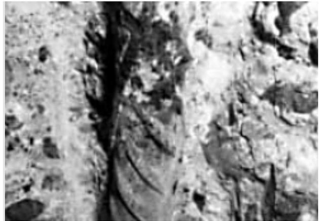
*Beginnende punktförmige Korrosion an einem Bewehrungsstab verursacht durch Chloride*
