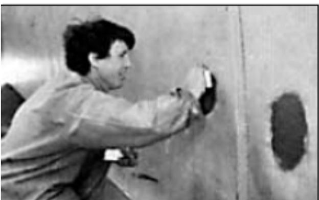
Bild D3.20 Die Sondieröffnungen müssen fachgerecht zugeputzt werden
