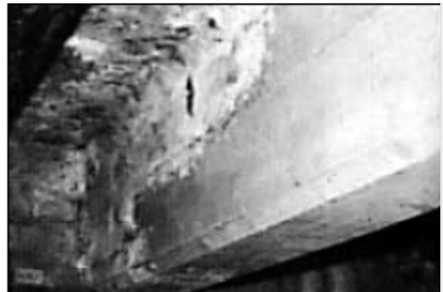
*Träger T2, linkes Widerlager W1: Kalkablagerungen im Bereich des Trägerendes und Randquerträgers RW1 infolge eindringendem Wasser*
