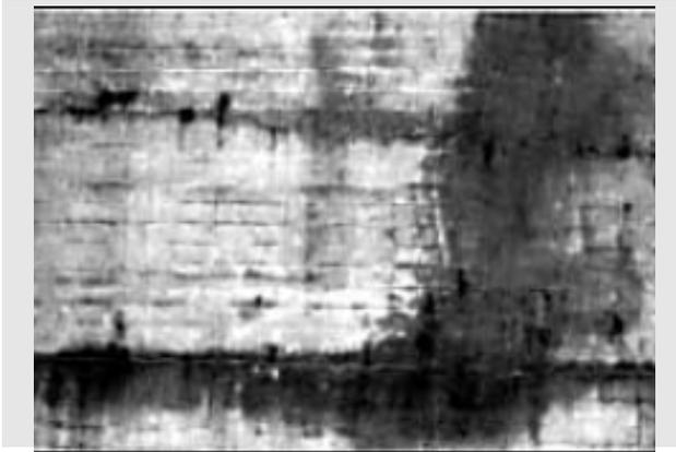
*Rostspuren verursacht durch ungenügende Betonüberdeckung der Bindedrähte*
