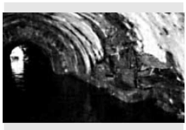
*Hohlstellen in Gewölbemauerung eines Durchlasses*
