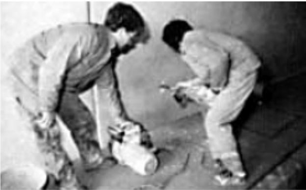
Bild D3.16 Aufspitzen von Sondieröffnungen zur Überprüfung der Überdeckungsmessungen sowie zur Bestimmung des Korrosionsgrades der Bewehrung
