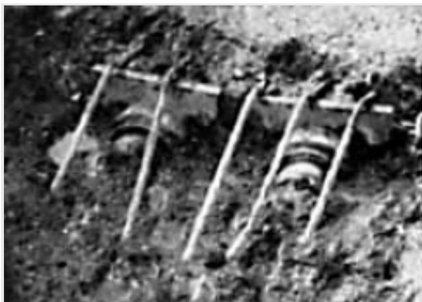
*Zu nahe an der Oberfläche liegende Kabelverankerungen sind korrosionsgefährdet*
