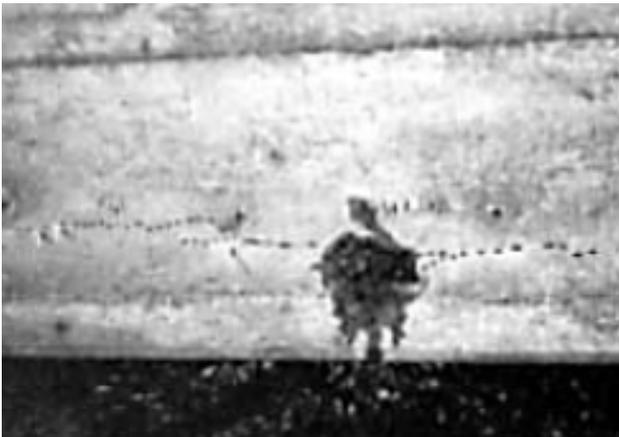
*Risse entlang Spannglied an der Betonoberfläche*
