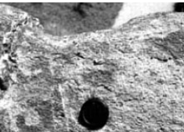
Bild 2.23 Stark abgewitterte Sandsteinbrüstung
