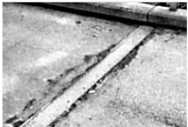
*Gelöste Befestigung eines Fahrbahnüberganges*
