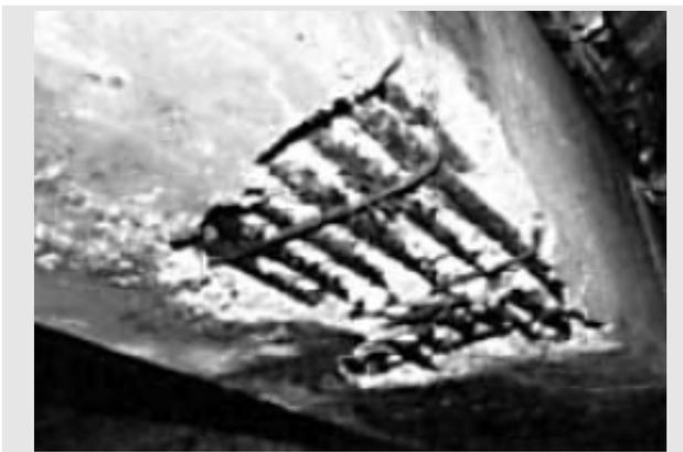
*Freiliegende Bewehrungsstäbe mit fortgeschrittener Korrosion*
