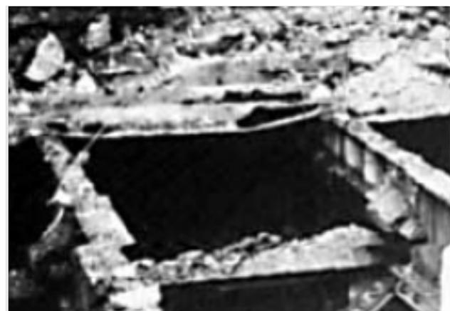
*Durchrostung, Trägerquerschnitt reduziert*
