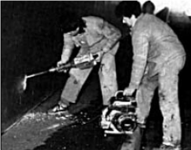
Bild 5.5 Hilfskräfte eingesetzt für das Öffnen von Sondierfenstern
