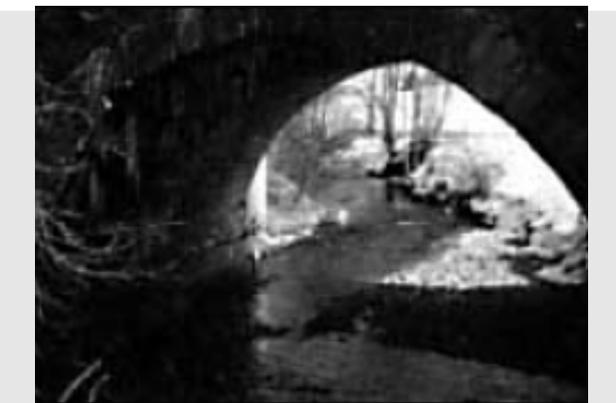
Eiszapfenbildung als Folge von Wasserdurchsickerungen durch Gewölbebogen
