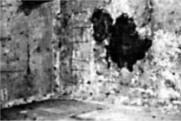
*Fahrbahnplatte FP zwischen den Trägern T2 und T3, Blick gegen Querträger Q: Kalkablagerungen infolge eindringendem Wasser durch Fahrbahnplatte, Entnahmestelle von Betonbohrkernen*
