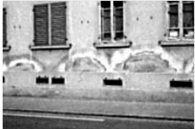
Bild 6.2 *Beeinträchtigung der Gebrauchstauglichkeit durch hochsteigendes Wasser im Mauerwerk*
