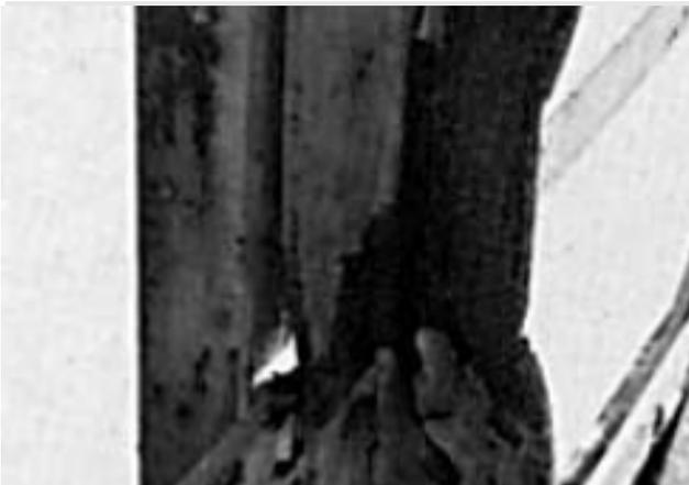
*Fachwerkstab verformt durch mechanische Einwirkung*
