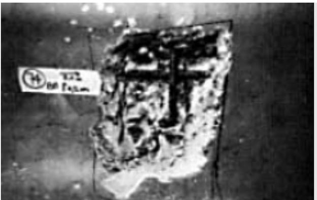
Bild D3.18 Die Sondieröffnungen werden fotografiert (wichtig ist die Identifizierbarkeit im Bild)
