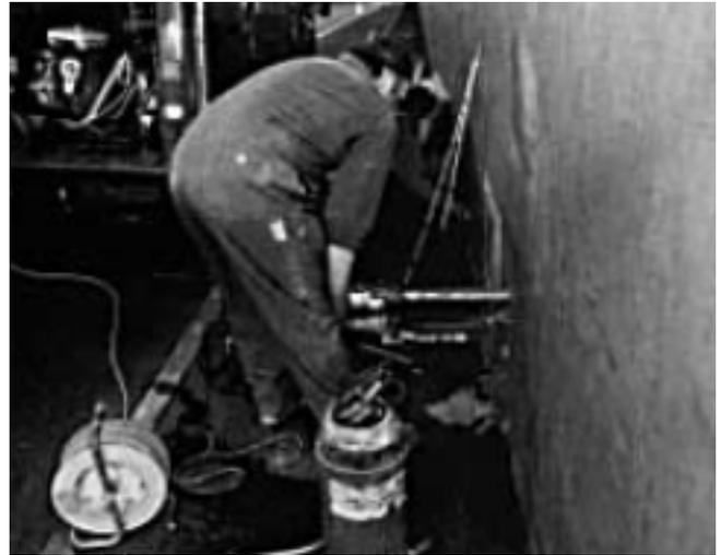
*Bild 5.7 Für die Ausführung von Kernbohrungen ist die Versorgung mit Strom und Wasser abzuklären*
