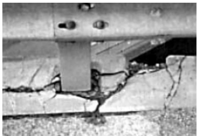
*Zerstörte Pfostenbefestigung in Mauerkrone*
