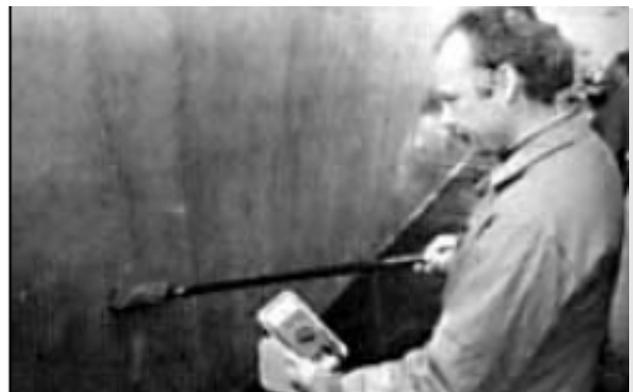
*Bild D3.9 Vorbereitende Messungen für die Potentialmessung: ist die Bewehrung genügend gut vermascht und ist der Anstrich nicht zu stark elektrisch isolierend?*
