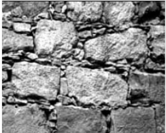
Bild 2.24 Bruchsteinmauerwerk mit stark verwittertem Fugenmörtel
