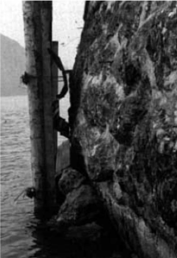
Bild 2.22 Stark verformtes altes Bruchsteinmauerwerk
