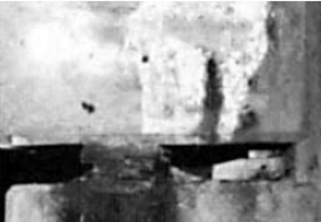
*Rostspuren infolge Korrosion an Lagerkörper*
