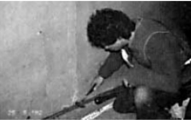
*Bild D3.12 Das wichtigste Werkzeug für die visuelle Untersuchung ist der Spitzhammer*
