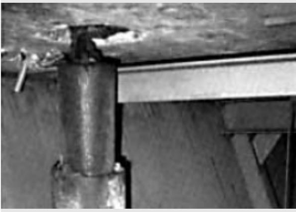
*Undichter Einlauf der Brückenentwässerung*
