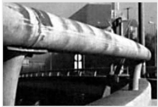
*Korrosion an einem ursprünglich verzinkten Stahlgeländer infolge Abtrag der Verzinkung*
