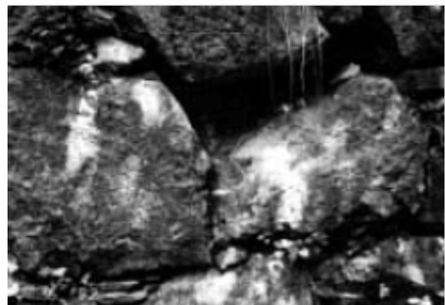
Bild 2.25 Altes Bruchsteinmauerwerk mit herausgefallenen Steinen und Pflanzenwuchs
