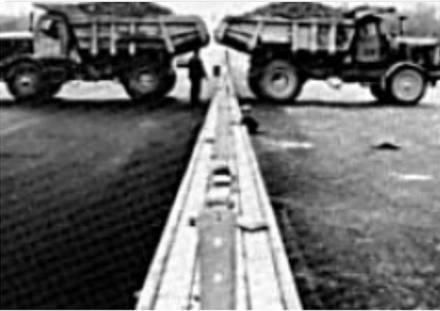
Bild 5.20 Belastungsversuch an einer Brücke
