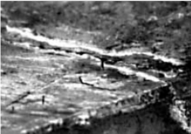
*Wasserführender Riss in Brückenplatte*
