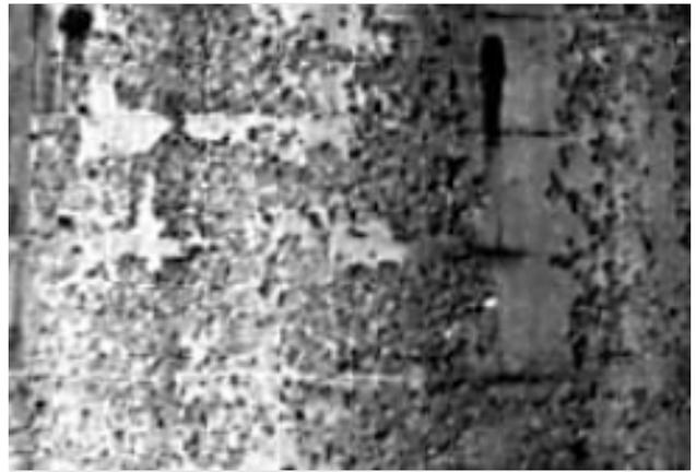
*Absanden der Betonoberfläche*
