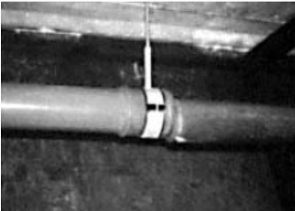
*Im Innern eines Brückenkastens gebrochene Entwässerungsleitung*
