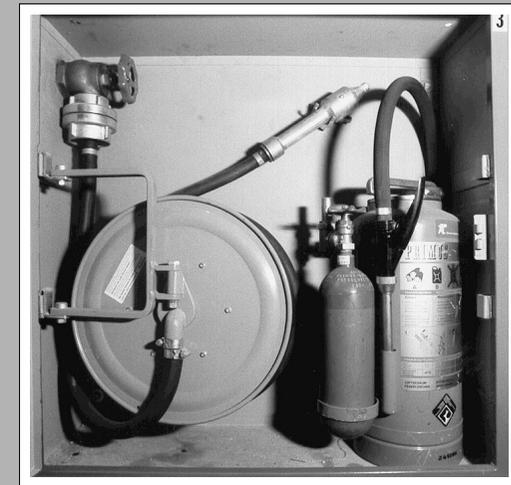
Feuerlöscheinrichtung mit Mundstück, Luft-schaum-Löcher und Druckluftflasche
