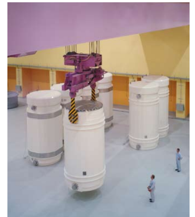
Zwischenlager für radioaktive Abfälle in Würenlingen. Foto: Zwiilag
