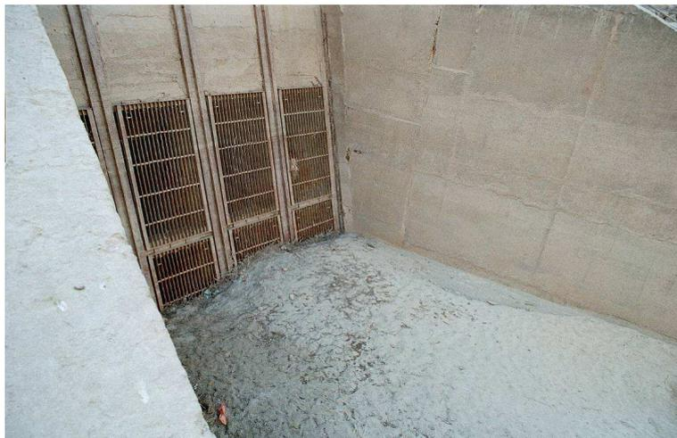
Sedimentation vor einem Kraftwerkseinlauf
