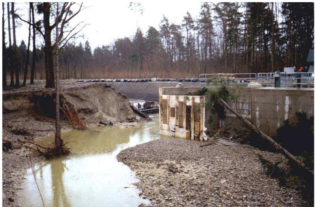
Kleinkraftwerk (Teil des Wehres rechts im Bild) nach dem Überströmen des seitlichen Bereichs, nachdem die Entlastungsschütze bei Hochwasser nicht öffnete
