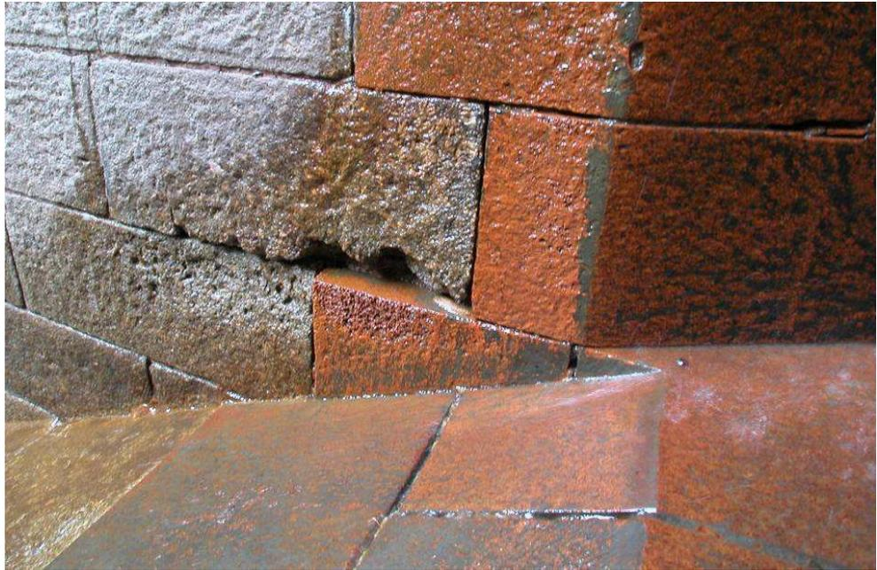
Erosion an hochwertigen Granitsteinen durch Unterdruck nach einer Kante
