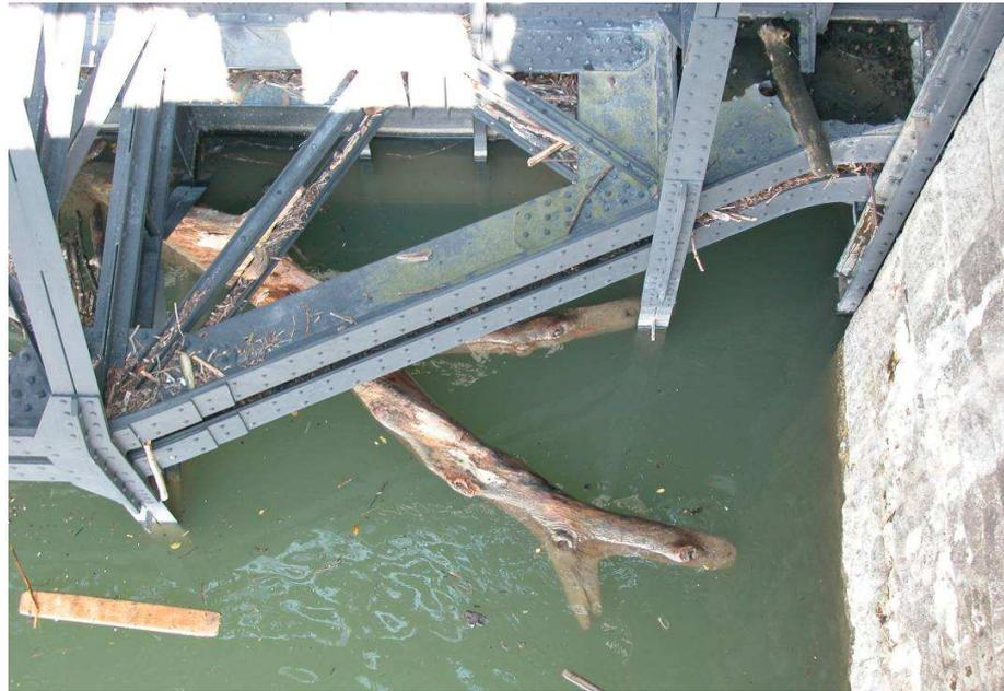
Verklemmter Baumstamm in aufgelöster Schützenkonstruktion
