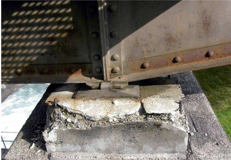
erhebliche Frostschäden im Auflager einer Wehrbrücke
