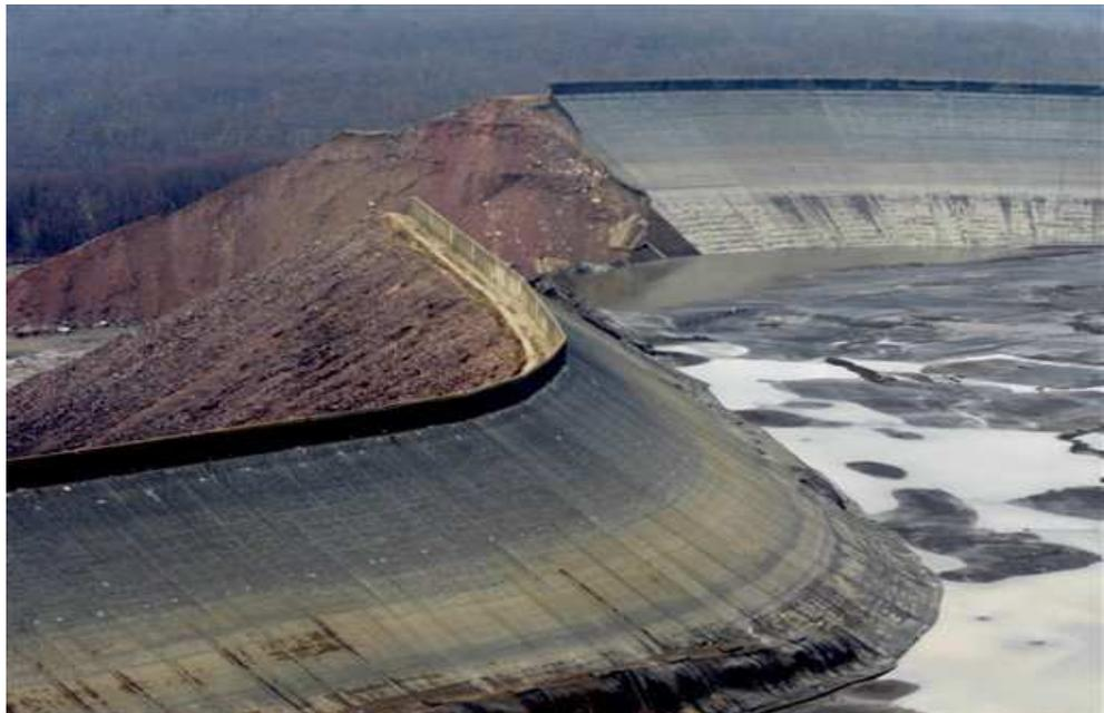
Dammbruch durch Überpumpen infolge falscher Messwertanzeige bei ungenügend befestigten Sonden (Taum Sauk, USA, Dez. 2005)
