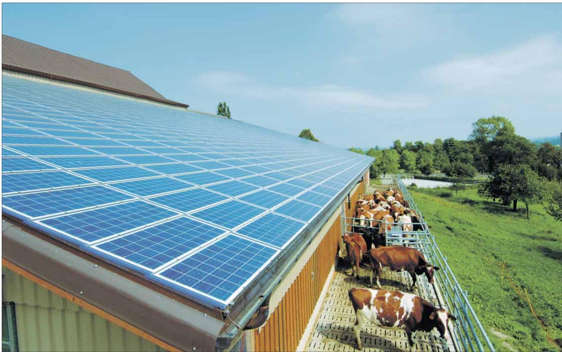
Die Solaranlage auf dem Dach des Laufstalls umfasst 960 m<sup>2</sup> und deckt über 300 Prozent des Energiebedarfs. (Foto: Karl-Heinz Hug)
