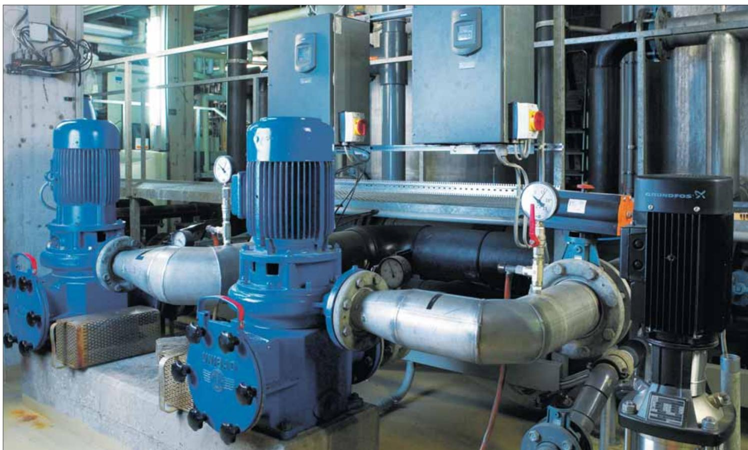
Der Einbau von Frequenzumformern (graue Kästen) ermöglicht eine stufenlose Einstellung der beiden Umwälzpumpen. Im Normalbetrieb laufen sie heute mit einer Leistung von lediglich 45 Prozent.
