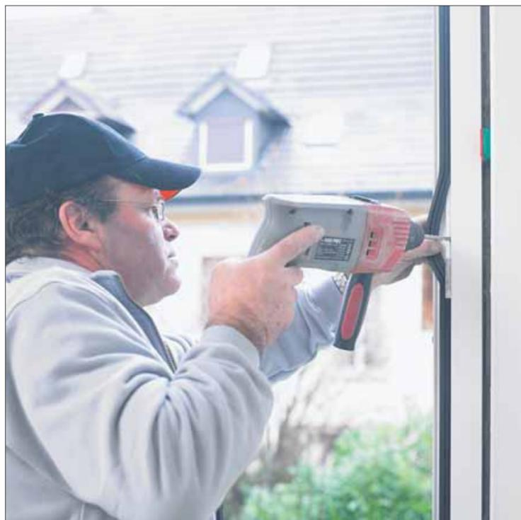
**6 Die Schrauben werden verdeckt unter der Gummiabdichtung angebracht.**
