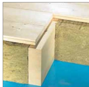
Auf den Balken wird ein neuer Riemenboden verlegt, der auch höchsten Belastungen standhält.
