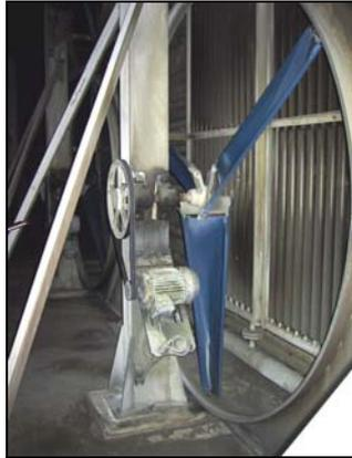
**Ventilatoren in den Trockenkammern: Drehzahlregulierung spart 24% Energie.**
