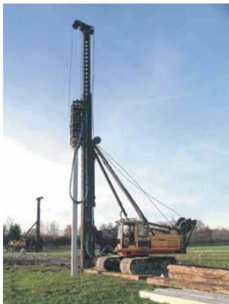
Abbildung 4.6: Rammpfahl (Bild: enercret Röthis).
