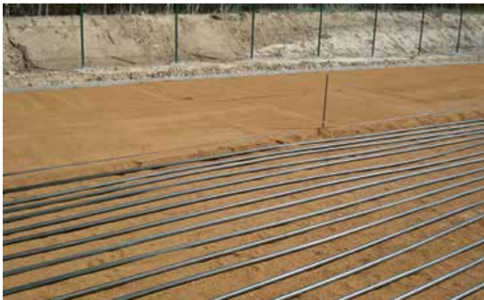
Abbildung 4.10: Neuanlage eines Erdwärmeregisters. Dieses wird anschliessend wieder mit Erdreich überdeckt (Quelle: HakaGerodur).
