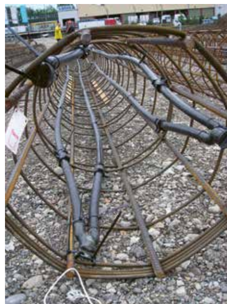
Abbildung 4.7: Pfahlarmierungs- korb mit befestigten Sonden (Quelle: HakaGerodur).
