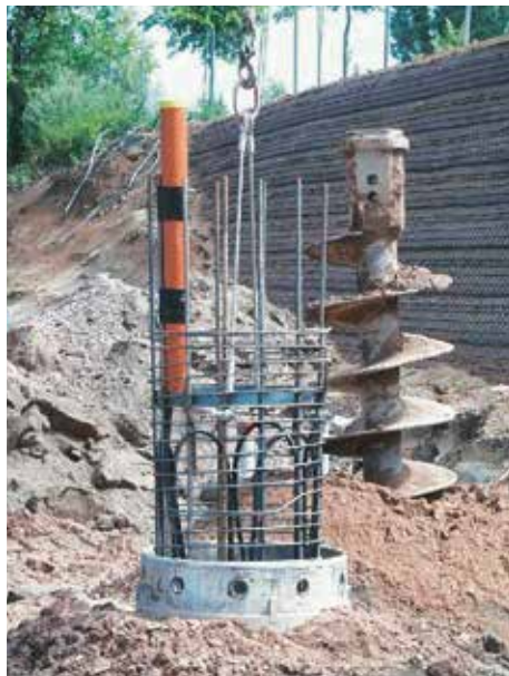
Abbildung 4.5: Bohrfahl (Bild: enercret Röthis).
