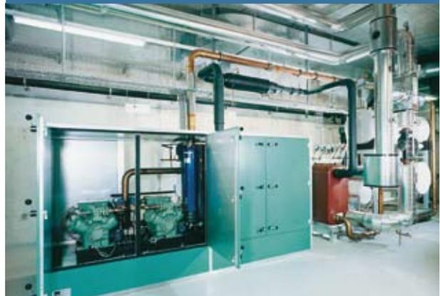
Aus 12-gradigem Abwasser wird 60-gradiges Heizwasser: Die Technik der Wärmepumpe macht es möglich. (Foto: Morf)
