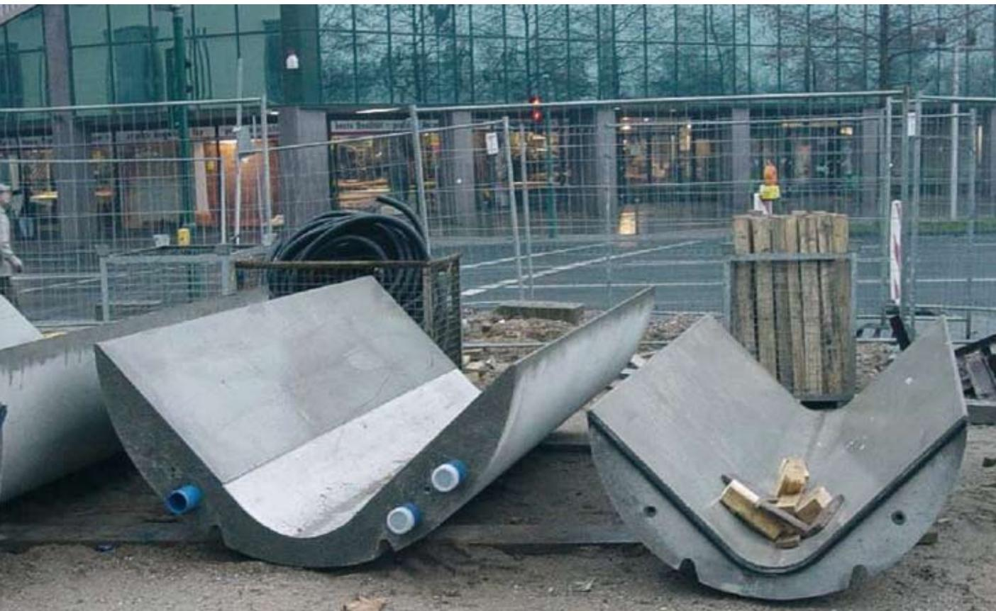
Viele Teile einer Anlage zur Abwasserwärmenutzung sind sehr dauerhaft. Bei Kanalwärmetauschern wird beispielsweise mit einer Lebensdauer von bis zu 50 Jahren gerechnet. Entsprechend hoch kann die Abschreibungszeit der Investitionen angesetzt werden. (Foto: TBL)
