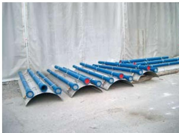
Wärmetauscher-Elemente vor dem Einbau. (Foto: Rabtherm)
