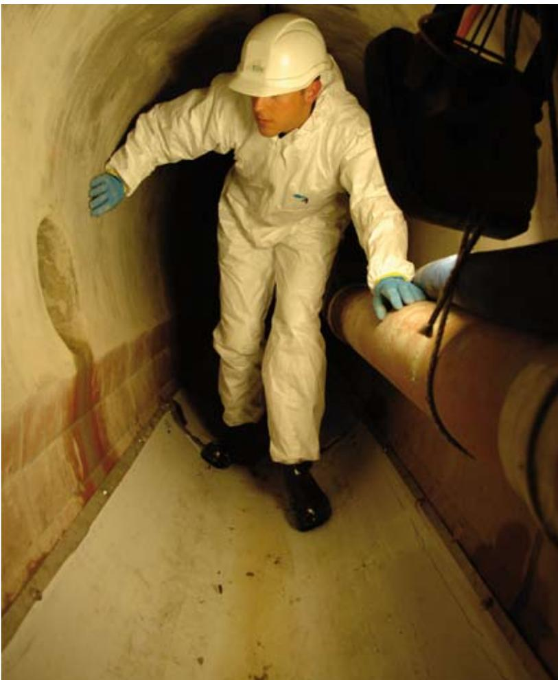
Letzte Kontrolle: Sobald Abwasser fließt, gewinnt der rinnenförmige Wärmetauscher in der Kanalsohle Energie. (Bild EBM)
