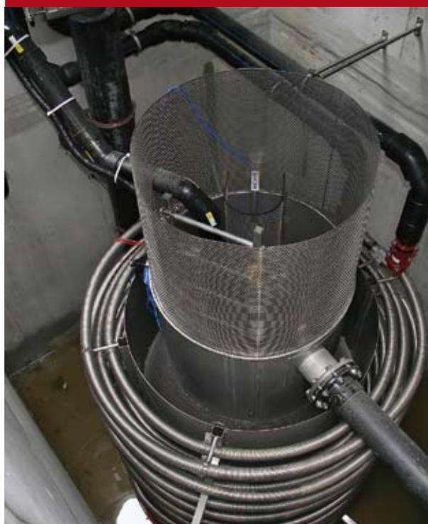
Bei der hausinternen Wärmerückgewinnung wird das Abwasser vor der Einleitung in die Kanalisation in einem Sammelschacht gespeichert, wo über 75% des Energiegehaltes im Abwasser mittels eines Wärmetauschers (Bild) zurückgewonnen werden können.
