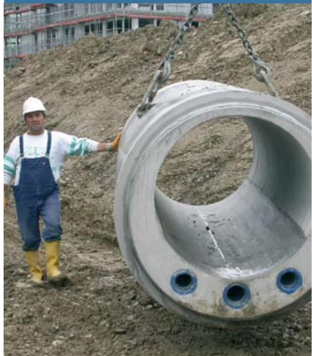
Mittels eines Kanalwärmetauschers wird der Kanalisation Wärme entzogen. (Foto: Uhrig)
