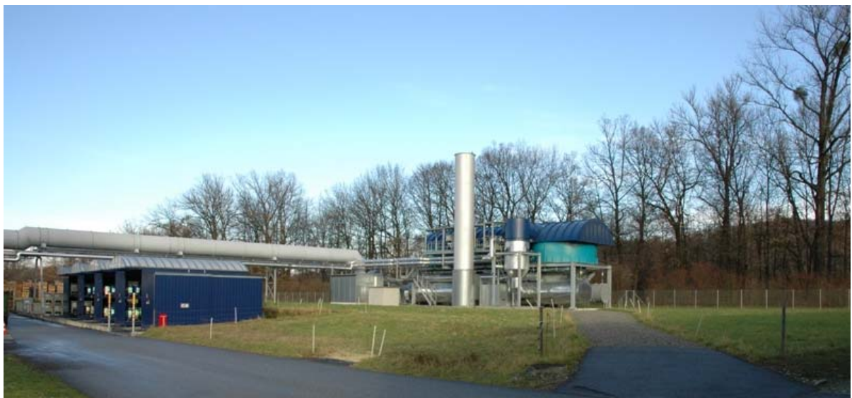
Ansicht der Regenerativen Nachverbrennungsanlage bei AMCOR
