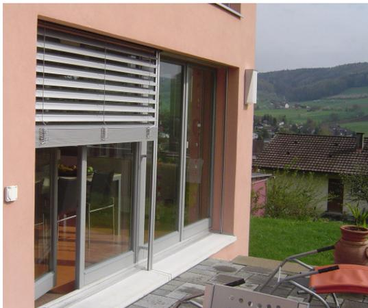
Abb. 4: Verschattung zur Kombination mit thermisch aktiver Fussbodenfläche
