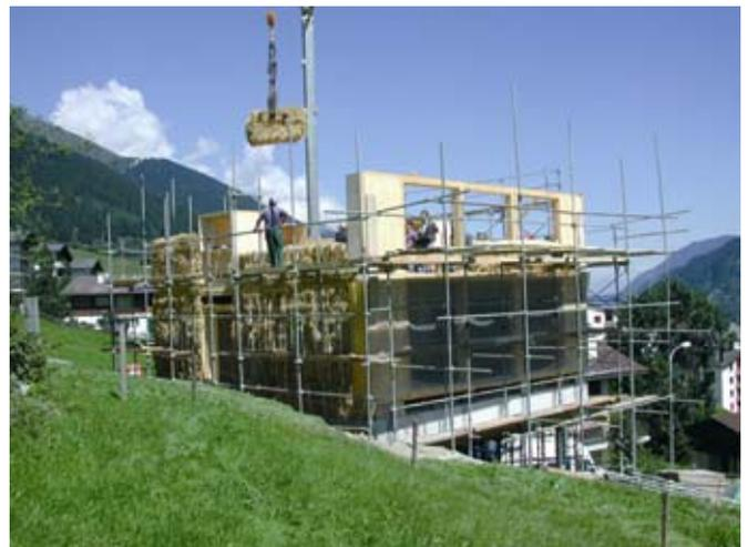
Fig. 6: Aufbau des Strohballen-Einfamilienhauses in Disentis mit „Jumboballen“ (120 cm dick). Quelle: Werner Schmidt (CH)
