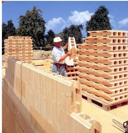
*Fig. 8: Holzmodul-Stecksystem
