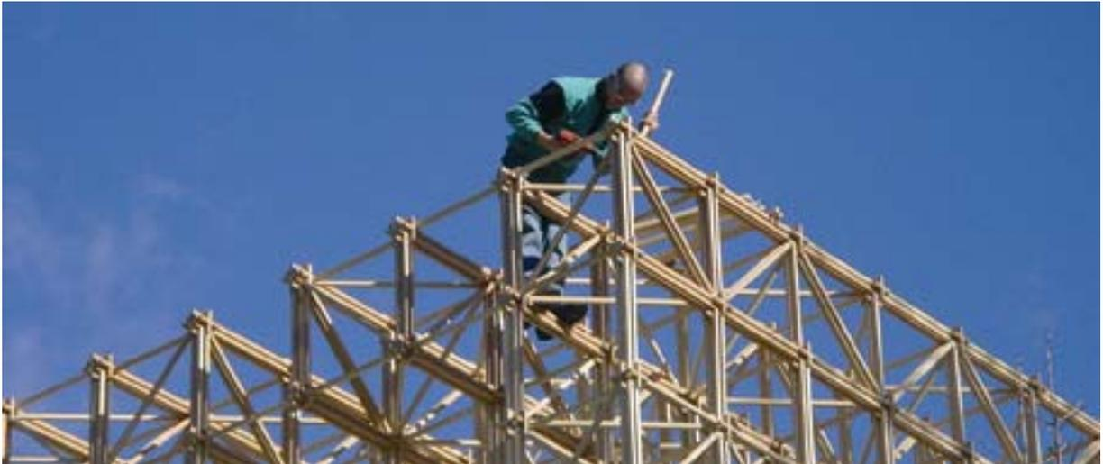
Fig. 1: Raumfachwerk: Holzstäbe und Zellulosedämmung bilden die Gebäudehülle. Quelle: David Muspach, Hochwald (CH)
