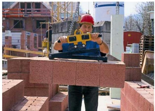
Fig. 11: Versetzen der Blähtonsteine mittels mechanisch gesteuertem Versetzgerät.
