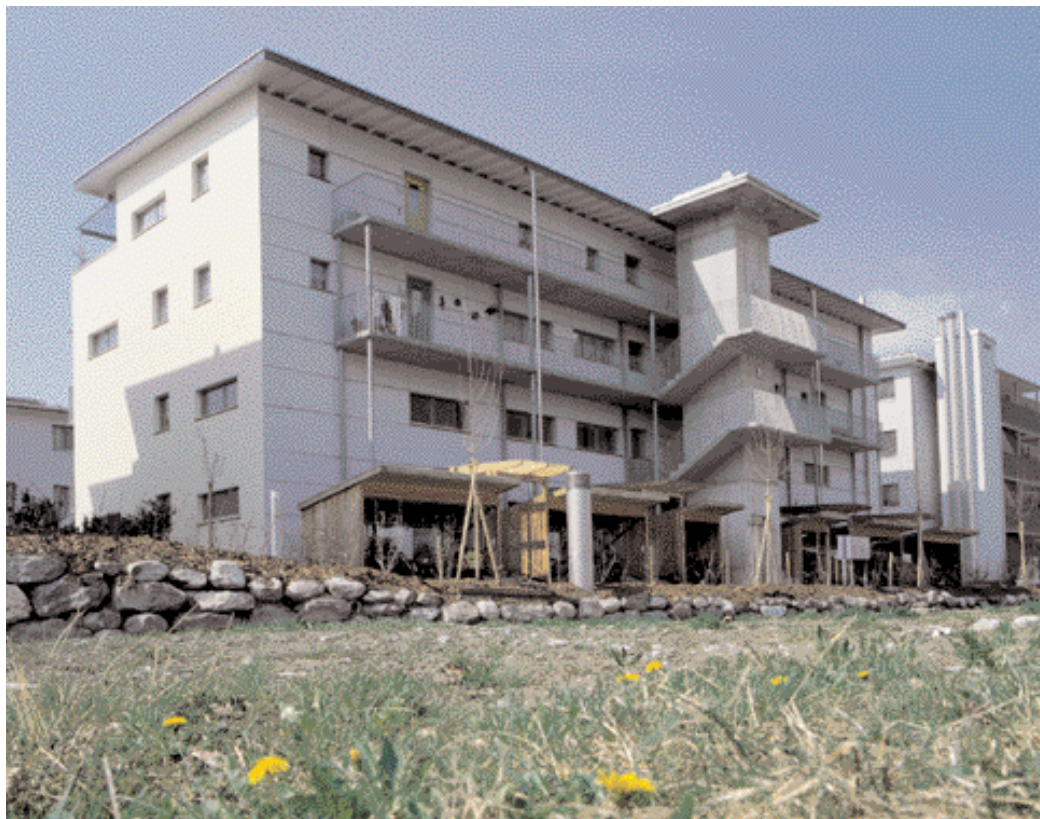
Nordfassade mit Erschliessungskern, Laubengängen und kleinen Fensteröffnungen
