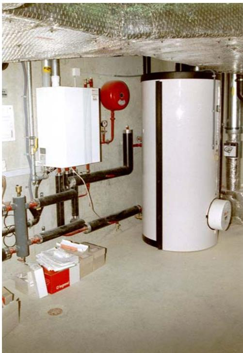
*Abbildung 3: Brennwert - Gastherme und Warmwasserspeicher im Technikraum Untergeschosses.*
