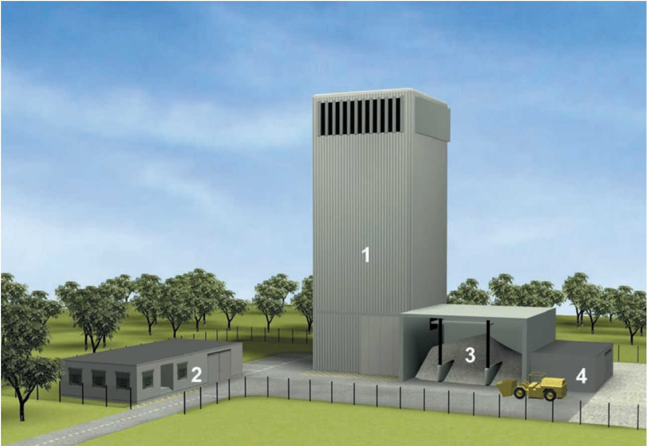
Figur 10 Modellhafte Ansicht des Schachtkopfbereichs mit dem Förderturm mit Abluftöffnungen (1) und mit Hilfsgebäuden (2 bis 4).
