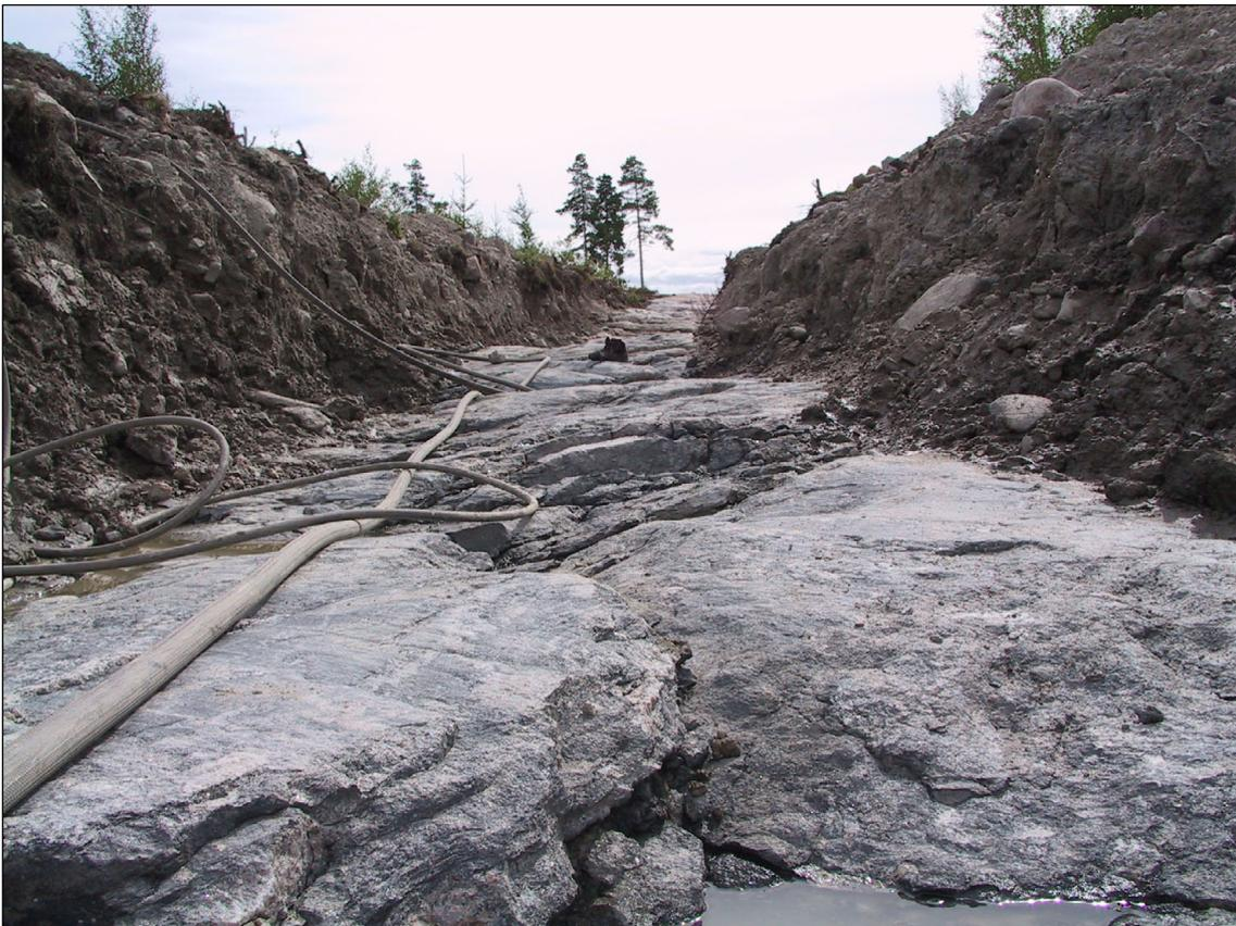
Fig. 4-3: Freilegung der Oberfläche des kristallinen Grundgebirges durch streifenweise Entfernung der Bodenschichten (*Trenching*), Olkiluoto, Finnland (Foto: Posiva).
