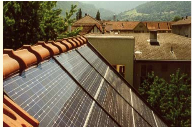
Gelungene Dachsanierung mit Solaranlage. (Raimund Hächler)
