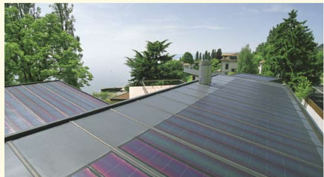
PV-Anlage mit Dünnschichtzellen aus amorphem Silizium.
